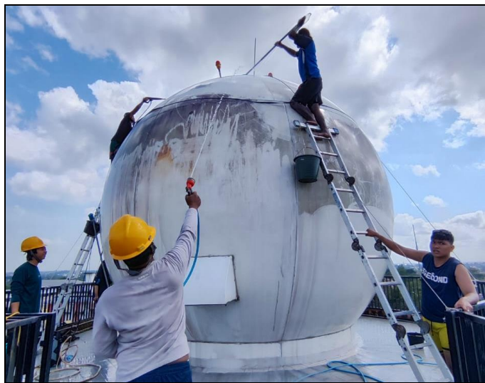
Gambar 28. Pemeliharaan Radome Radar Cuaca
